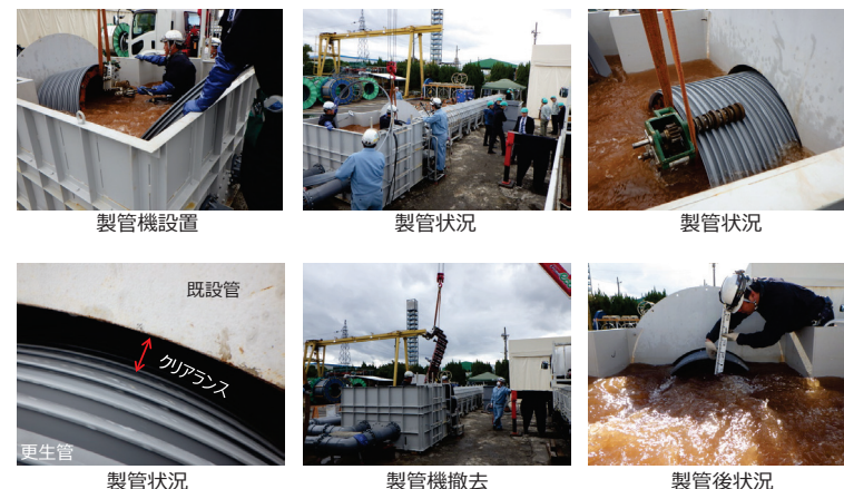
写真-3 作業状況(製管)
