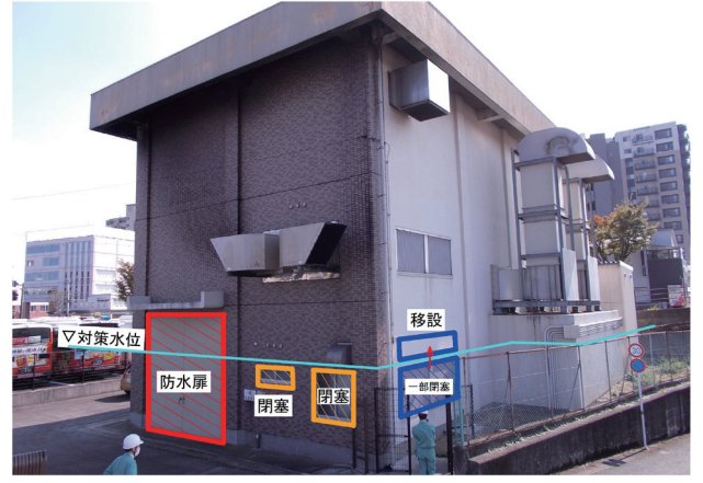
写真-1 外部開口に対する対策
