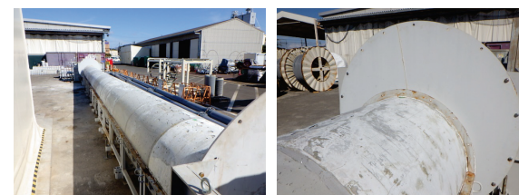
裏込め材充填状況
