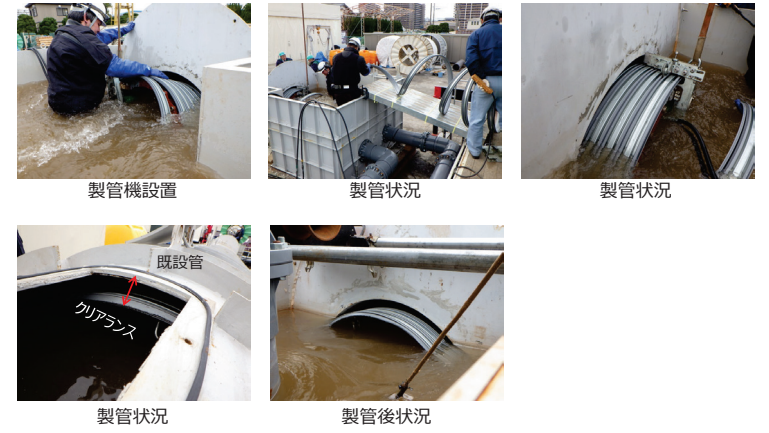
写真-8 作業状況(製管)
