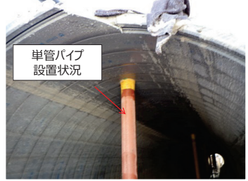
写真-7 管口・浮上防止工設置位置付近の状況
