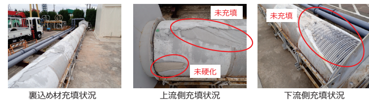
写真-6 裏込め材の充填状況
