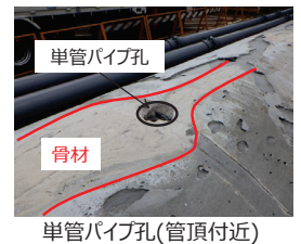
写真-7 管口・浮上防止工設置位置付近の状況
