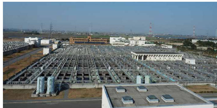
矢作川浄化センターの水処理施設全景
