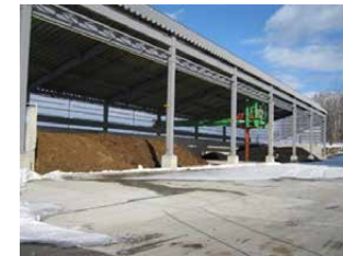
写真1 堆積発酵場の例
