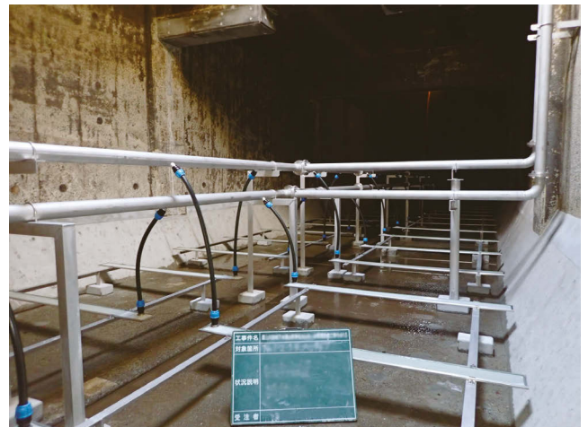
写真-5 低圧損型メンブレンパネル設置時（山形浄化センター）
